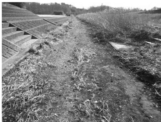
瀬切れした野川（小金井新橋下流・平成18年2月撮影）
