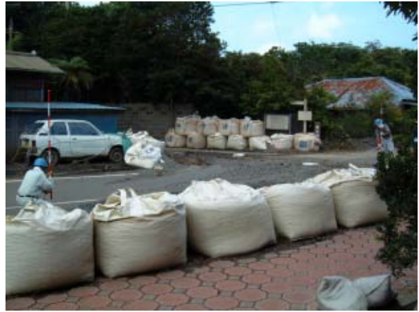
1トン土のうによる応急対策
