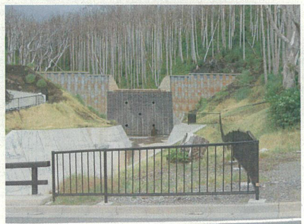
仏沢 1 号ダム(高さ 10.5m 長さ 49.8m) ダブルウォールダム(平成 13 年度完成)
