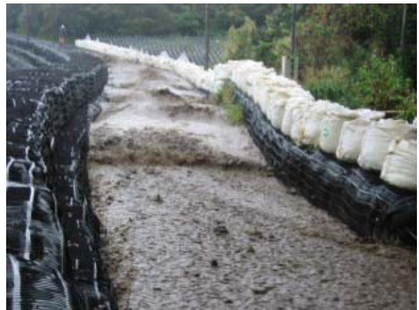
大型土のうと1トン土のうで施工された仮導流堤を流れる泥流(釜方沢)
