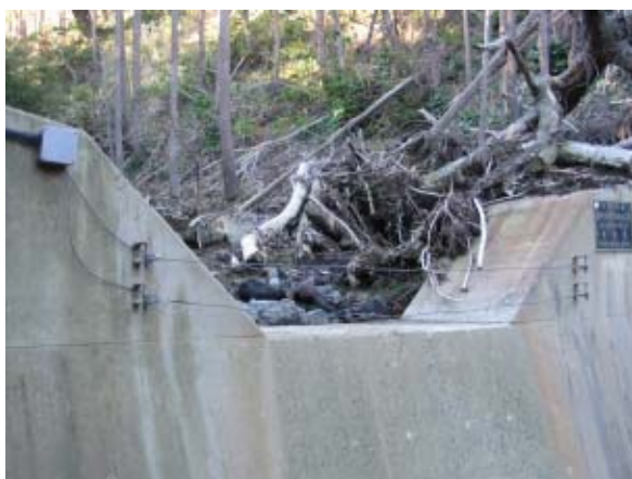
釜の尻沢のワイヤセンサー設置状況(左)とワイヤ局(右)
