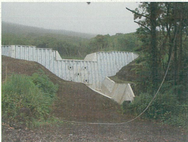
筑穴沢(高さ 11.0m 長さ 107.2m) ダブルウォールダム(平成 14 年度完成)
