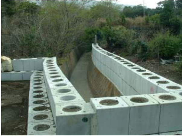
コンクリートブロックによる流路工嵩上げ
