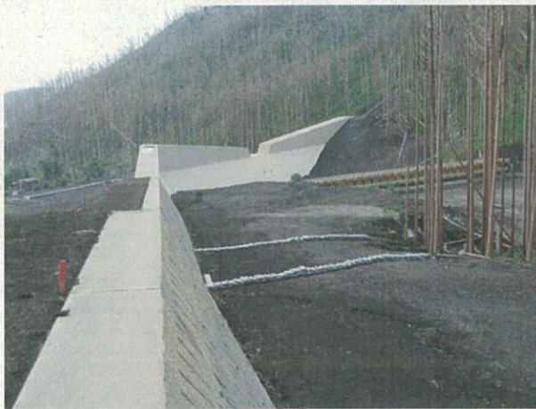
三池地区の沢(高さ 9.5m 長さ 252.3m) コンクリートダム(平成 15 年度完成)
