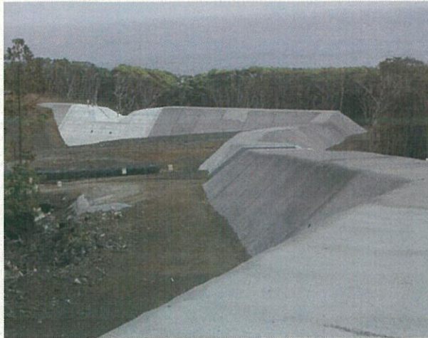
釜方沢(高さ 10.0m 長さ 690.0m) ソイルセメントダム(平成 14 年度完成)
