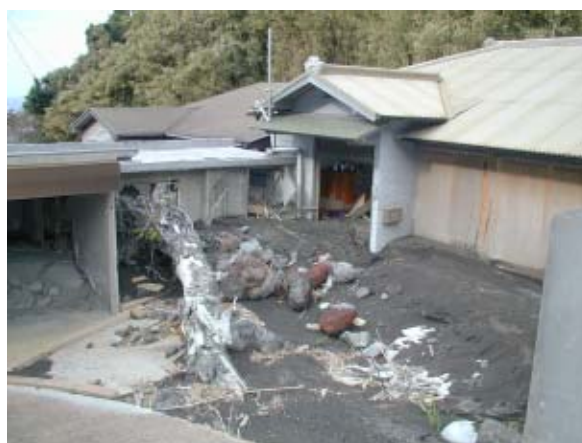
泥流、流木による家屋の被害(伊ヶ谷地区)
