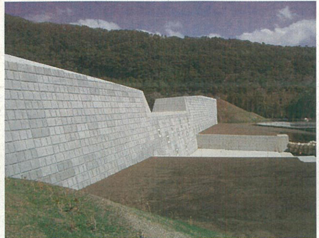
道の沢(高さ 8.5m 長さ 510.0m) ソイルセメントダム(平成 18 年度完成)
