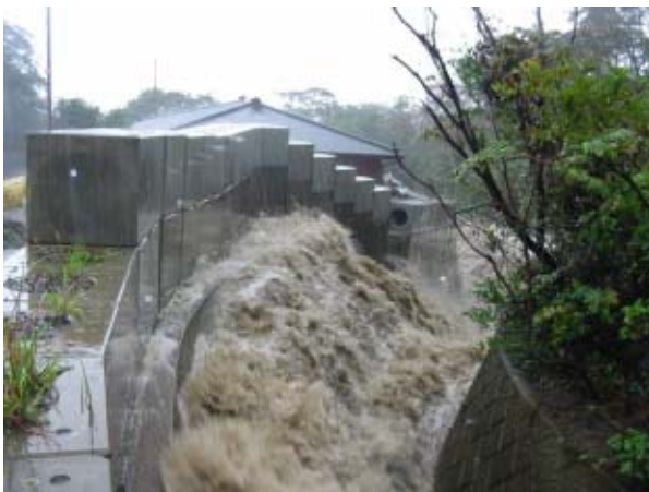
コンクリートブロックにより嵩上げされた流路工を流れる泥流(川田沢)
