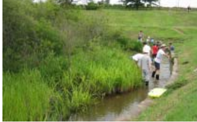
繁茂植物の除去と清掃
