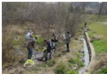
風塵の泥土を除去する作業
