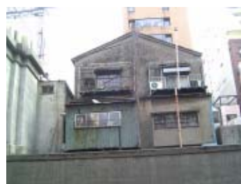
民家も川に向けた面はまるで 無防備である
