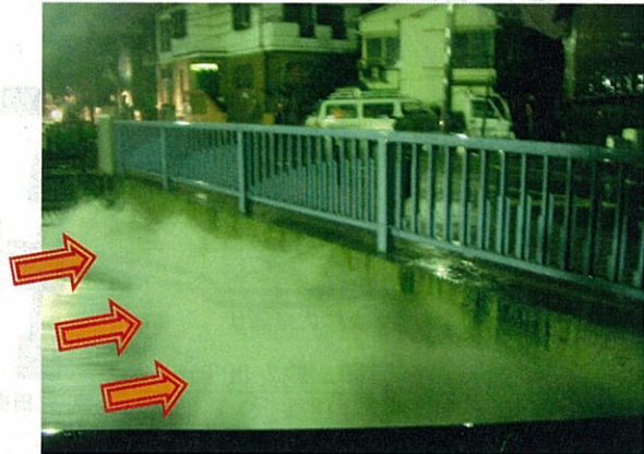
橋桁に洪水が激しくあたっている状況 (妙正寺川：中野区松が丘二丁目付近)
