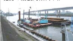
堤防の耐震対策(中川)
