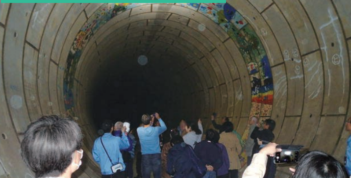
神田川・環状七号線地下調節池インフラツアー
