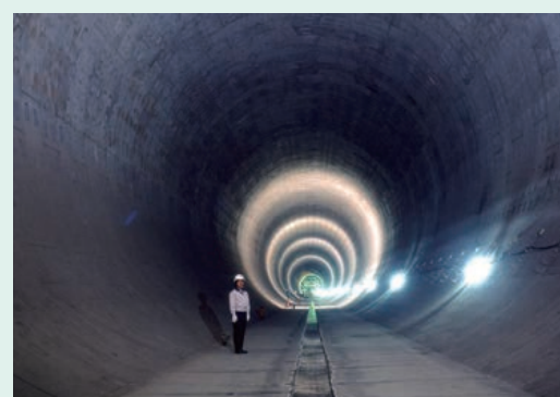
神田川・環状七号線地下調節池
