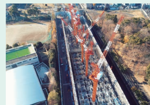
城北中央公園調節池整備中(石神井川)
