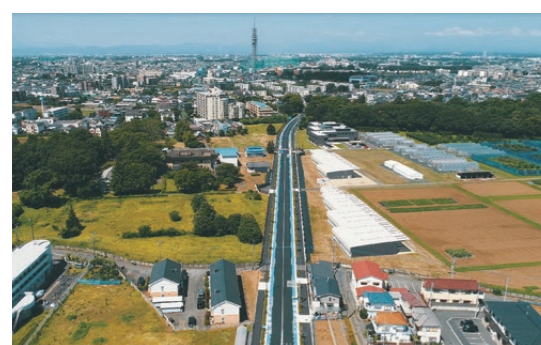
西東京3・4・9号線(令和3年8月2日交通開放)
