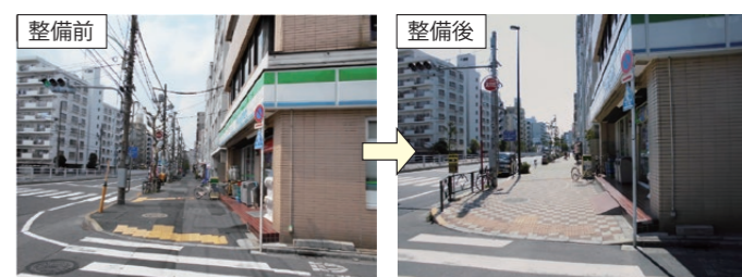
無電柱化 整備前後写真
