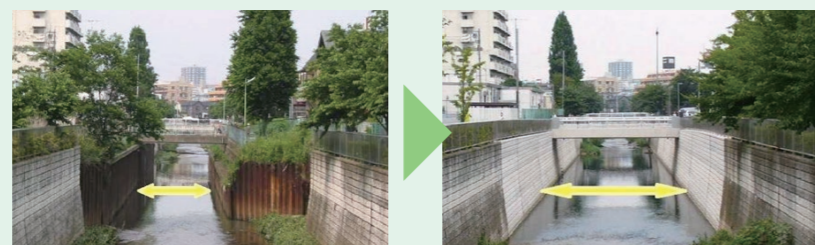
護岸改修前後の比較(石神井川)
