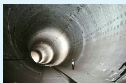
神田川・環状七号線地下調節池
