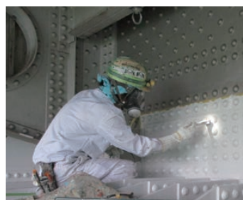
塗装の塗替え(勝開橋)
