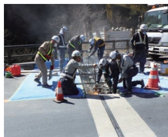
伸縮装置の取替(和田下橋)
