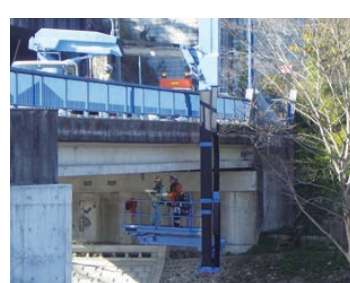
橋梁点検(秋川橋)
