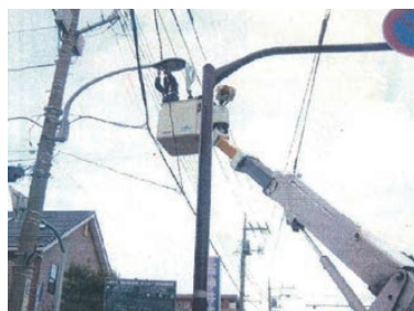
街路灯のランプの取替
