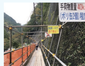
仮設歩行者用通路(正面)
