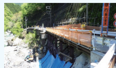
仮設道路(側面)
