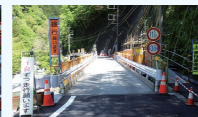
仮設道路(正面)
