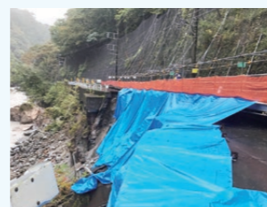
仮設歩行者用通路(側面)
