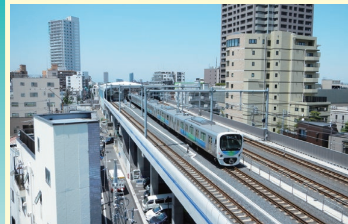
西武池袋線(練馬高野台駅～大泉学園駅間)
