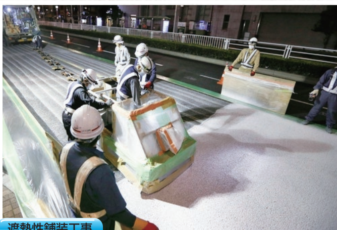
遮熱性舗装工事
