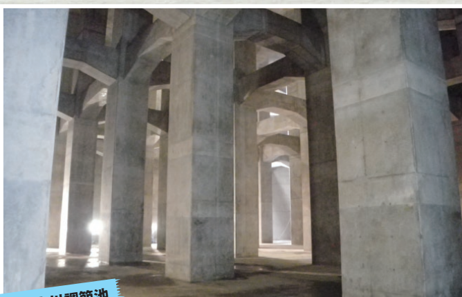
善福寺川調節池
