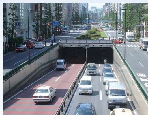
開削トンネルの例
