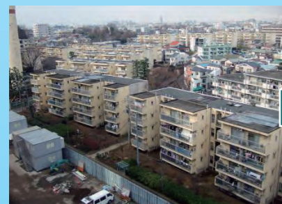
平成22年1月都営アパート解体前
