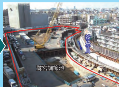
平成25年2月工事施工中の様子
