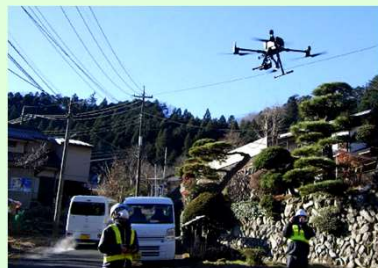
UAV点検実施状況
