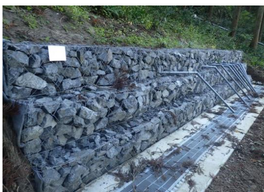
図6 多摩部(あきる野市) 横ボーリング工
