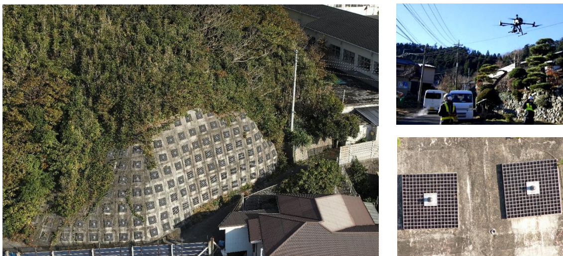
図 19 計測事例（UAV による写真計測）
