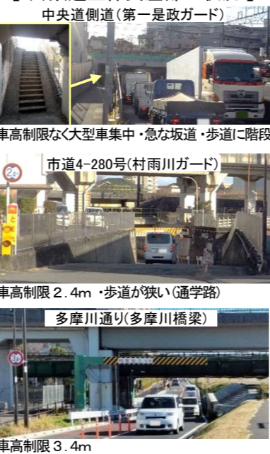
【(3)鉄道立体交差部の状況】
