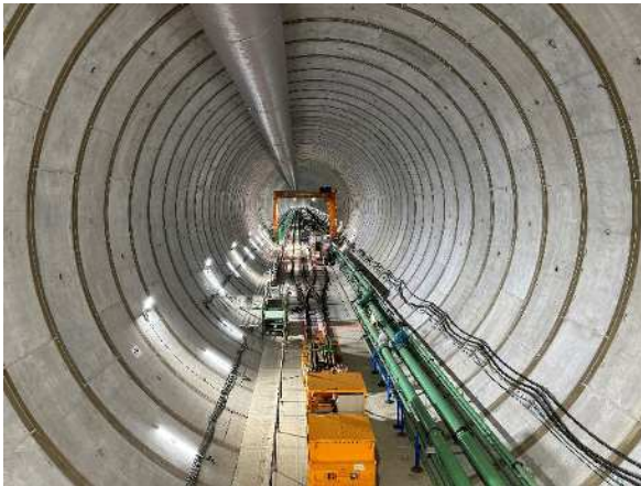
シールドトンネル施工状況 2023年9月 約400m地点より
