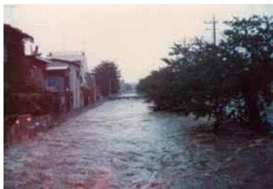
石神井川の増水状況 (昭和 57 年 9 月 12 日)
