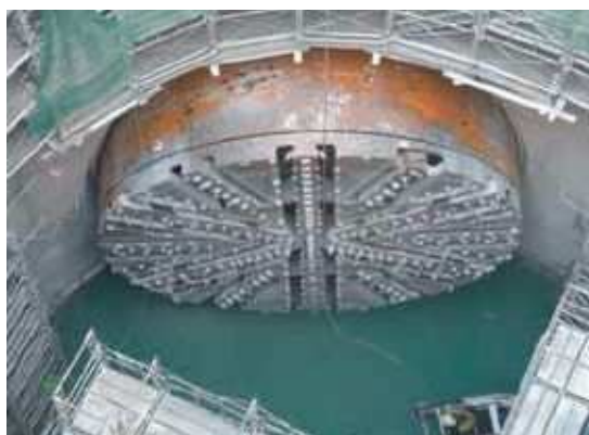
シールドマシン到達 (石神井立坑)
