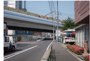
立体化完成 (I期区間)
